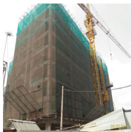
Block K2 (diện tích: 13.966,10m 2 , 12 tầng): hoàn thiện phần khung, bê tông cốt thép (cột, sàn) đến tầng 8.
