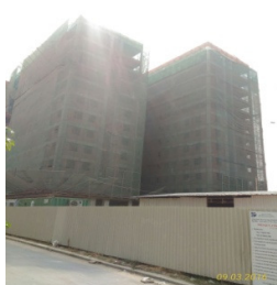
Block K1 (diện tích: 13.966,10m 2 , 12 tầng): hoàn thiện phần khung bê tông cốt thép đến phần mái
